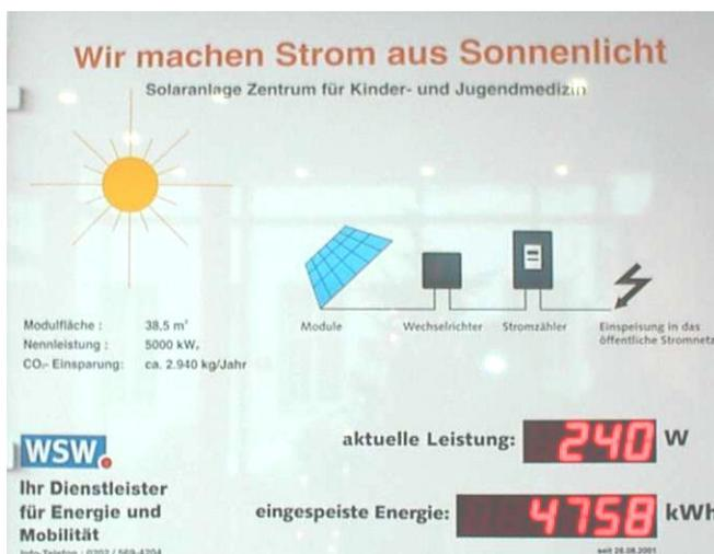
errichtet. Im Sommer 1999 ist die erste Fotovoltaikanlage auf dem Wuppertaler Schwebebahnhof Adlerbrücke in Zusammenarbeit mit den Wuppertaler Stadtwerken (WSW) und dem Land NRW ans Netz gegangen. Im August 2001 wurde auf Anregung des Klinikums Wuppertal eine fünf Kilowatt Solaranlage auf dem Zentrum für Kinder- und Jugendmedizin in Barmen errichtet.
