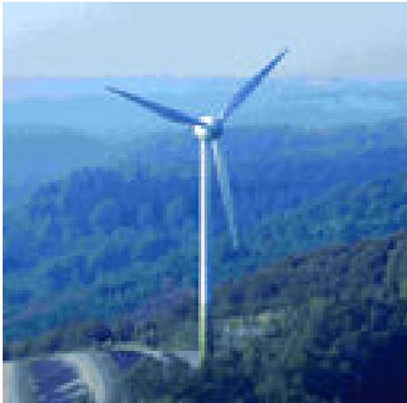
Die Nennleistung der immer noch ersten Windturbine in Wuppertal liegt bei 600 Kilowatt, der Ertrag bei 500.000 Kilowattstunden jährlich, was dem Strombedarf von etwa 150 Haushalten entspricht und pro Jahr circa 250 Tonnen Treibhausgas Kohlendioxid erspart. In bislang über 80.000 Betriebsstunden wurden seit der Inbetriebnahme insgesamt mehr als 6.000 Megawattstunden erneuerbare Energie erzeugt und der Umwelt blieben circa 3.500 Tonnen Treibhausgas Kohlendioxid erspart.
